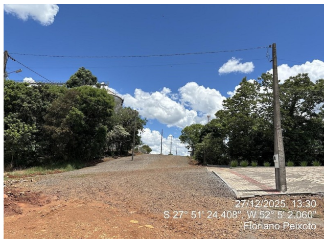
Foto 04 – Trecho da Rua Antônio Pauletti, frente da Capela Mortuária.
