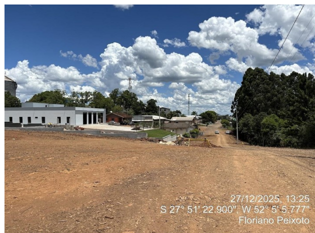
Foto 02 – Trecho da Rua Jacob Coltro frente da obra da nova UBS.
